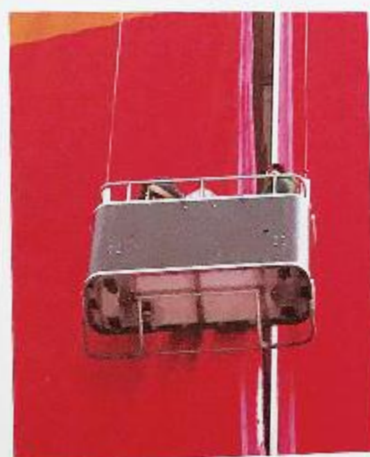
Das Riesenplakat besteht aus 36 Teilen, die mit Klettverschlüssen und elastischen Seilen untereinander verbunden sind.
